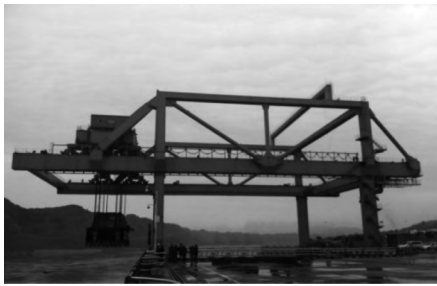
图 4 悬臂式钢结构基础的双跨桥吊
